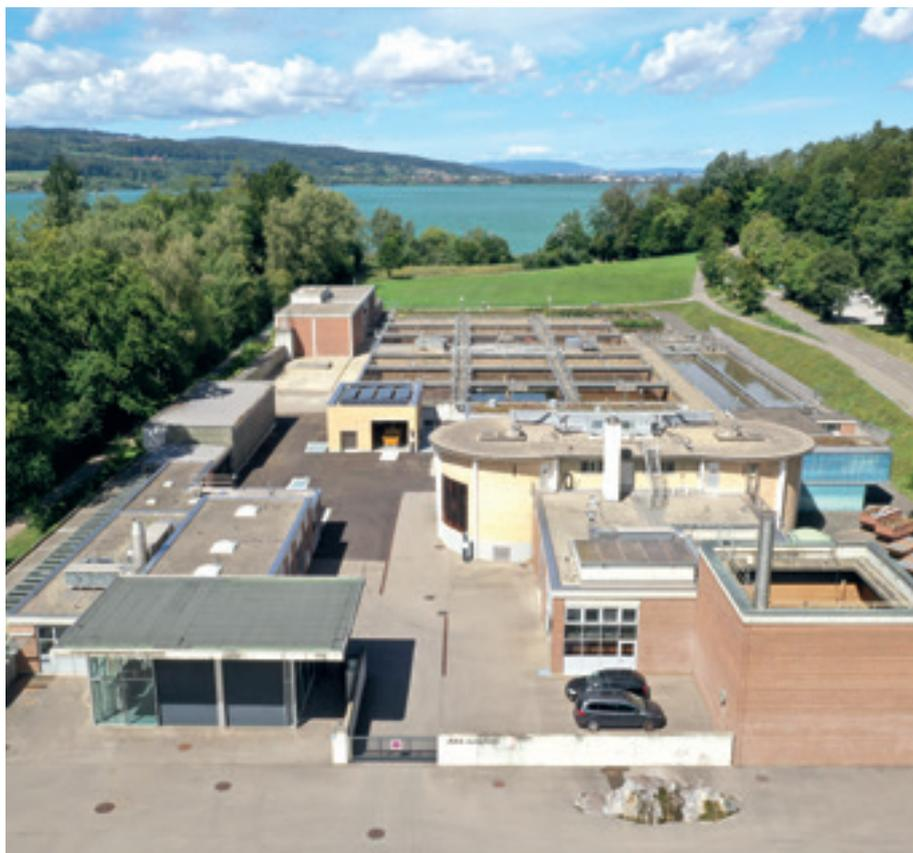
Nach der letzten grösseren Sanierung und Erweiterung der biologischen Abwasserreinigung von 2007 – 2011 wurde die Zeit genutzt, die Langfristplanung 2016 – 2035 zu entwickeln. Dies war notwendig, weil auf der gesetzgeberischen Ebene die Elimination von Mikroverunreinigungen aus dem Abwasser verankert wurde und das AWEL Amt für Wasser, Energie und Luft des Kantons Zürich festgelegt hat, dass auch die ARA Jungholz eine solche Stufe bauen muss.
