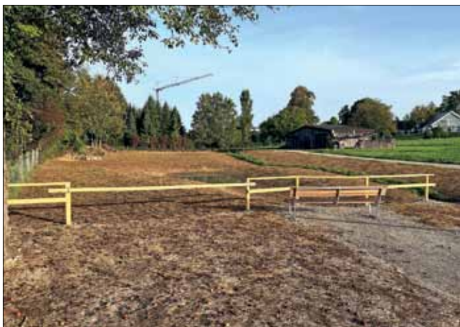
Die Aufwertungsfläche kurz nach Fertigstellung im Sommer 2023. Die (noch) kargen Rohbodenflächen sind mit Schnittgut einer Magerwiese begrünt.
