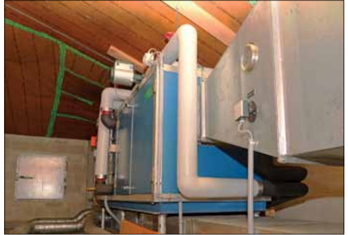
Die Lüftungsanlage über dem Pfarrraum wird komplett erneuert.
