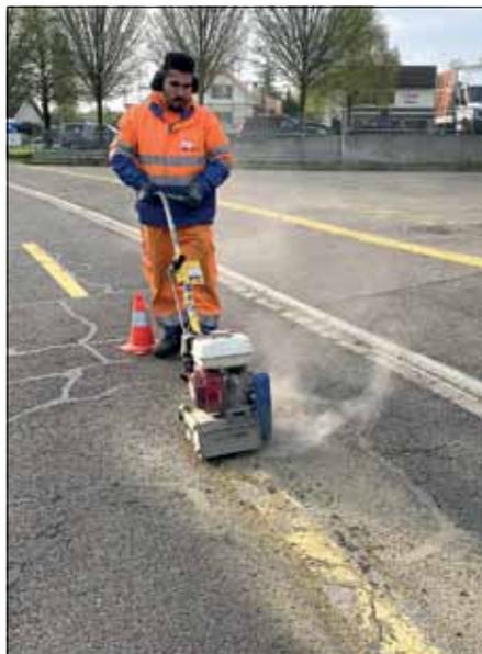
Mit einer Fräsmaschine werden die gelben Radwegmarkierungen entfernt. (rj)
